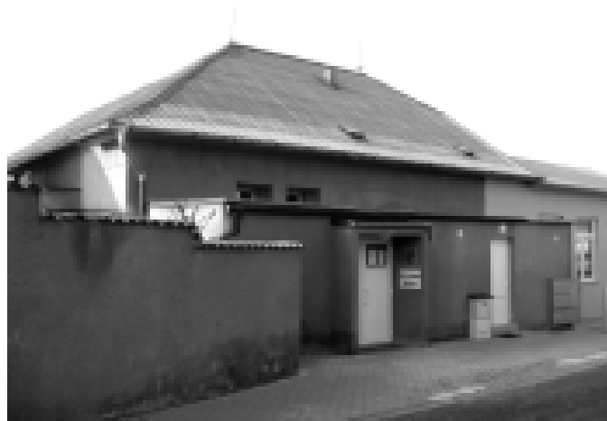
Budovu ZŠ v Navrátilově ulici čekají opět stavební úpravy
